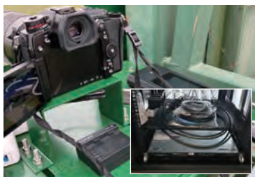
株式会社電通スポーツパートナーズ様 亜細亜大学様向けライブ配信設備
