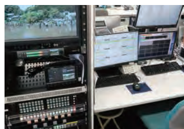
株式会社広域高速ネット二九六様 回線送出システム
