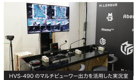
HVS-490 のマルチビューワー出力を活用した実況室
