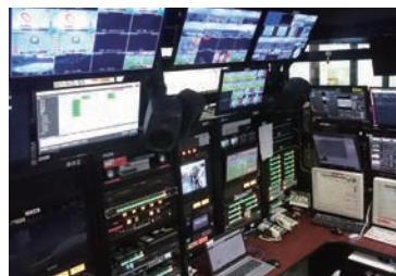
株式会社福岡放送様 リモートセンター回線設備
