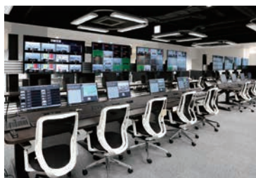
中京テレビ放送株式会社様 報道NVシステム 回線収録
