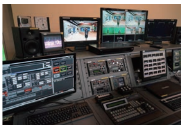
株式会社広域高速ネット二九六様 SmartDirectシステム
