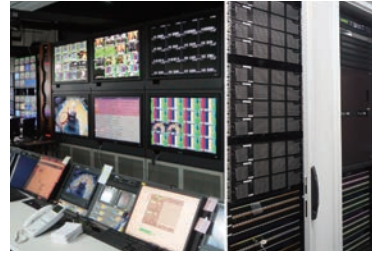
ネクシオン株式会社様 回線交換設備
