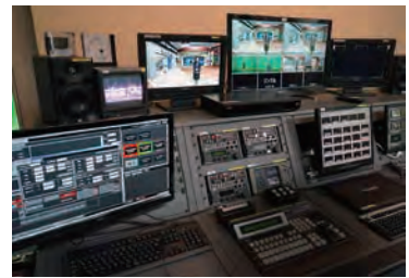
株式会社広域高速ネット二九六様 SmartDirect システム
