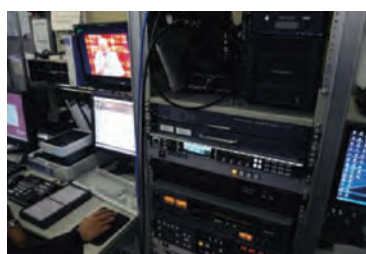
伊万里ケーブルテレビジョン株式会社様 メディアマネジメントシステム
